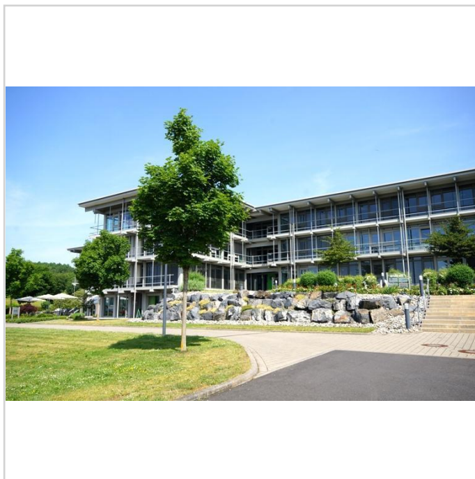
Ansicht des Gebäudes
